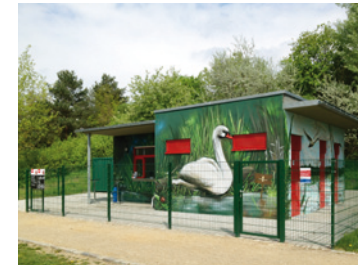
3 Kiosk mit Sanitäranlage
